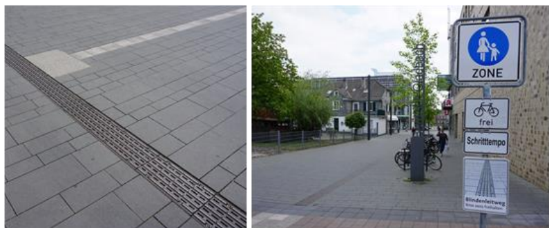
Abbildung 2-4: Taktiles Leitsystem in Kombination mit Entwässerung in der Fußgängerzone in Bergisch Gladbach (Fotos: Planungsbüro VIA)
