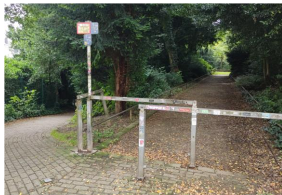
Abbildung 2-7: Fußwegeverbindung mit kontrastarmer, überlappender und engstehender Umlaufsperrung in Wuppertal (Foto: Planersocietät)
