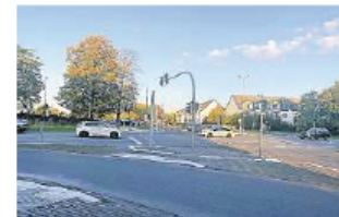
Die Ampelanlage an der Kreuzung Walhovener Straße/B9 soll angepasst werden.
