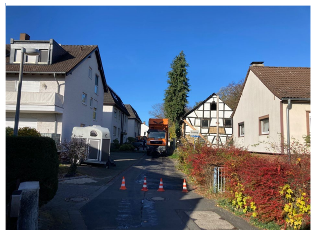
Abbildung 19: Gehwegsanierung in Lohmar (Foto: Stadt Lohmar)
